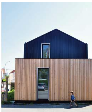
Figure 10 : Le volume d'étage se distingue grâce à un traitement différent (bardage bois / bardage métallique). L'un est couvert par un toit terrasse, l'autre par une couverture à deux pentes
