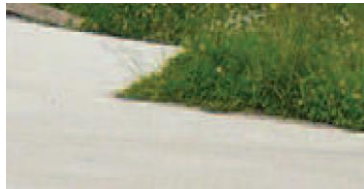
Figure 1 : Revêtement de sol en dalle béton
