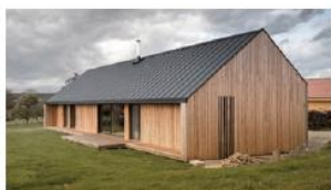
toiture bac acier, maison individuelle, Vezet(70)
