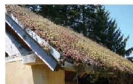
toiture en pente végétalisée Bazouges-sous-hédé (35)
