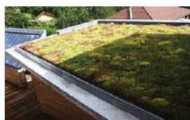
toiture terrasse végétalisée
